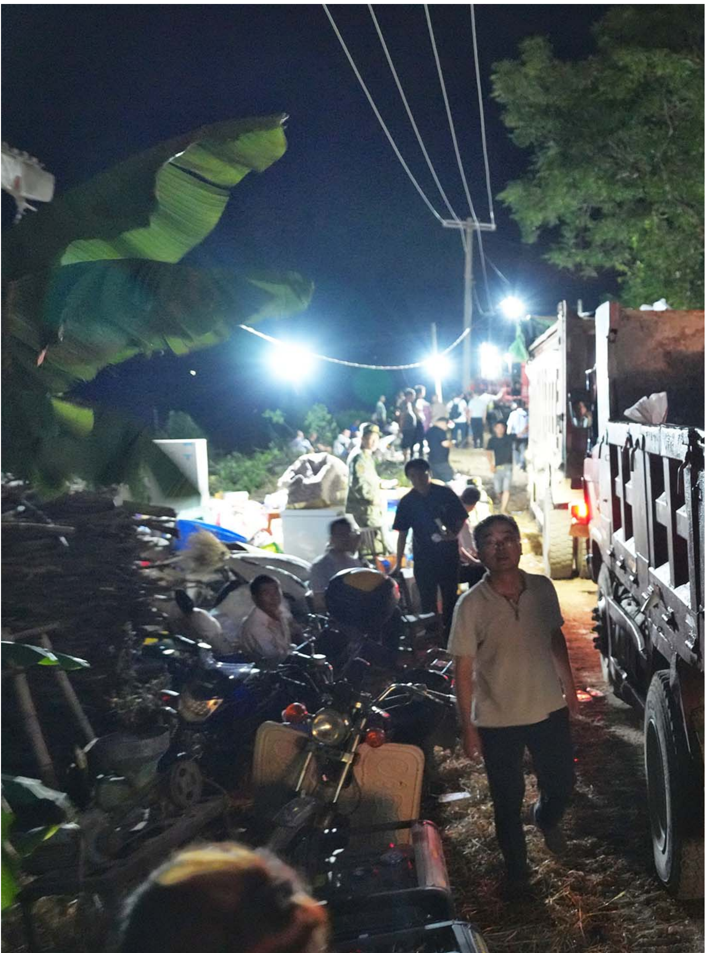
2024年7月5日，中国岳阳，一辆满载石块的卡车驶向堤防决口现场。摄：Yang Huafeng/China News Service/VCG via Getty Images
