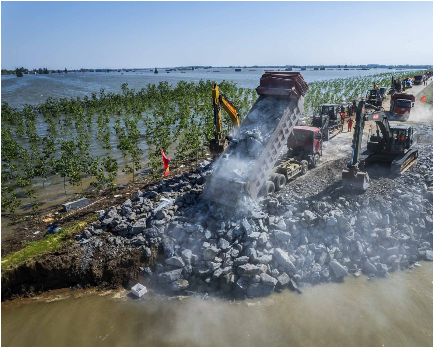
2024年7月6日，湖南湖南华容县团洲垸洞庭湖，救援人员在一线堤防决口完成封堵。摄：XINHUA/EPA/达志影像
