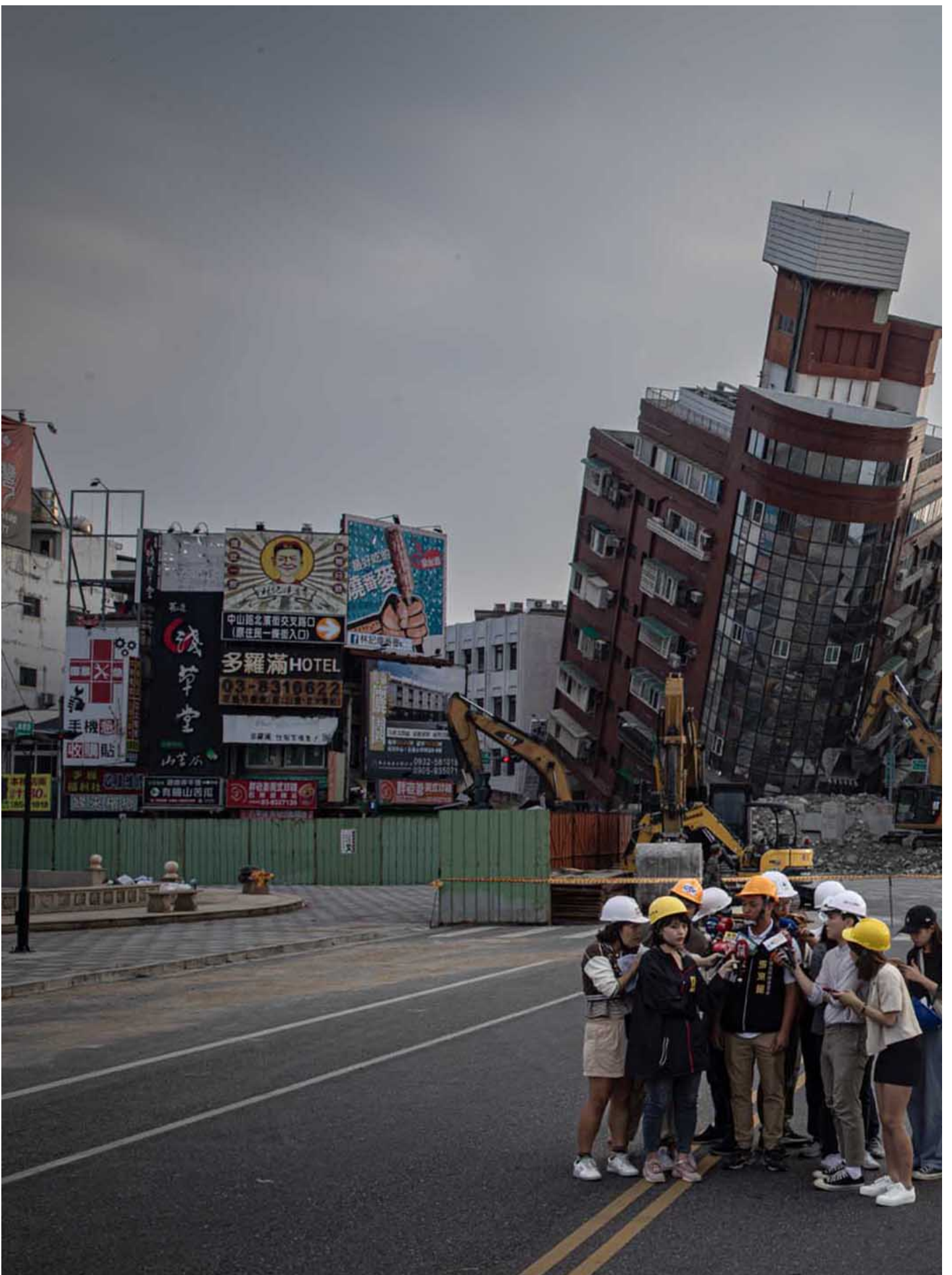
2024年4月4日，花莲，记者在因地震而塌倒的大楼旁采访。
