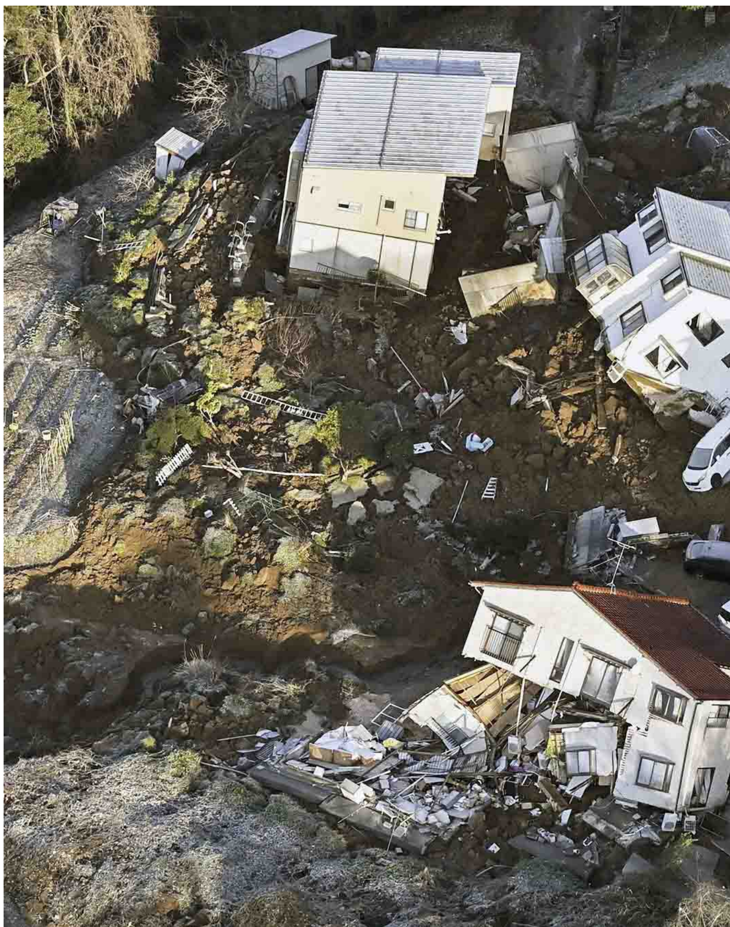
2024年1月2日，日本石川县金泽市地震造成倒塌的房屋、汽车和道路。摄：Kyodo/via Reuters/达志影像
