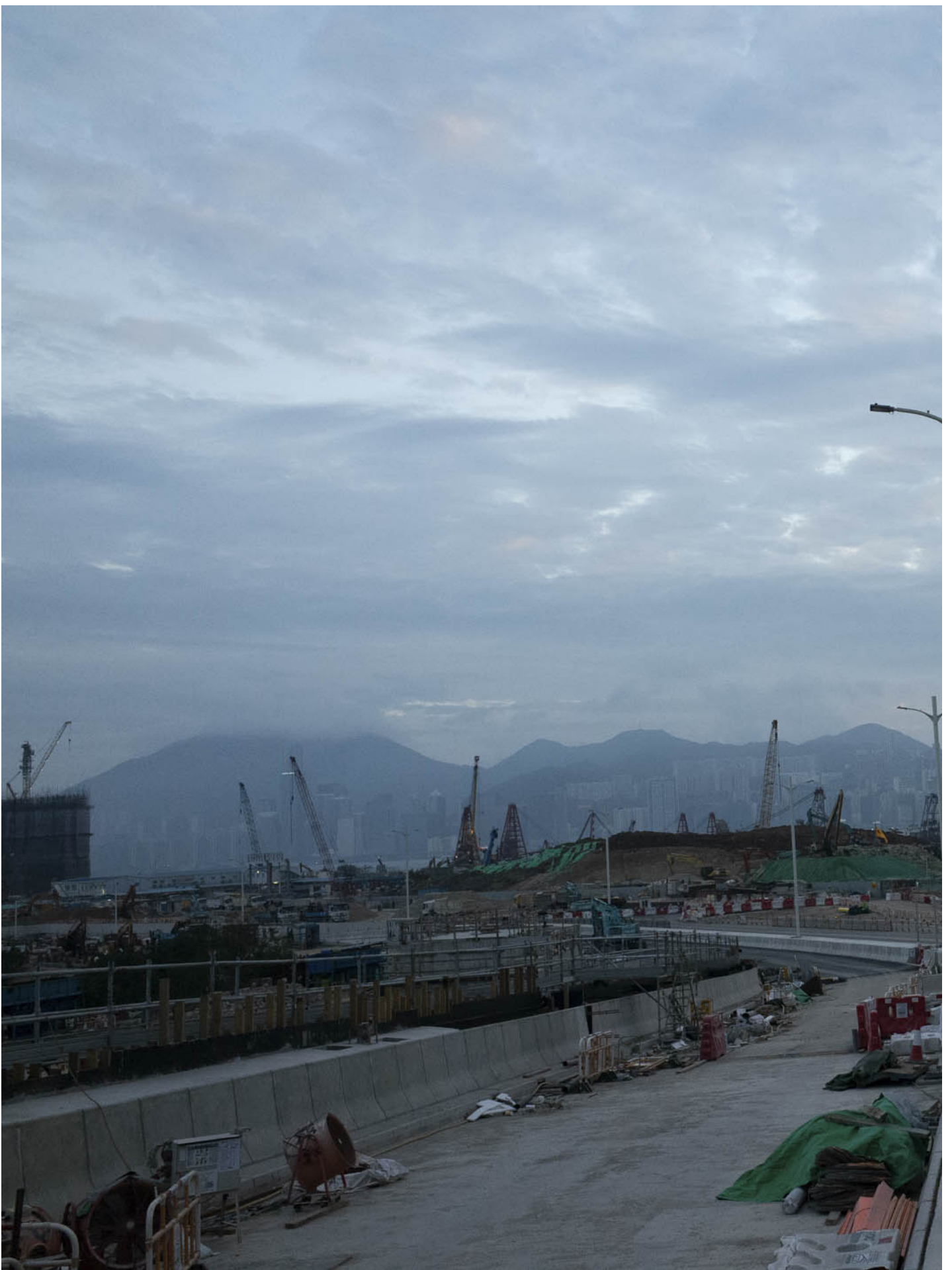
啟德，數個地盤正在動工。
