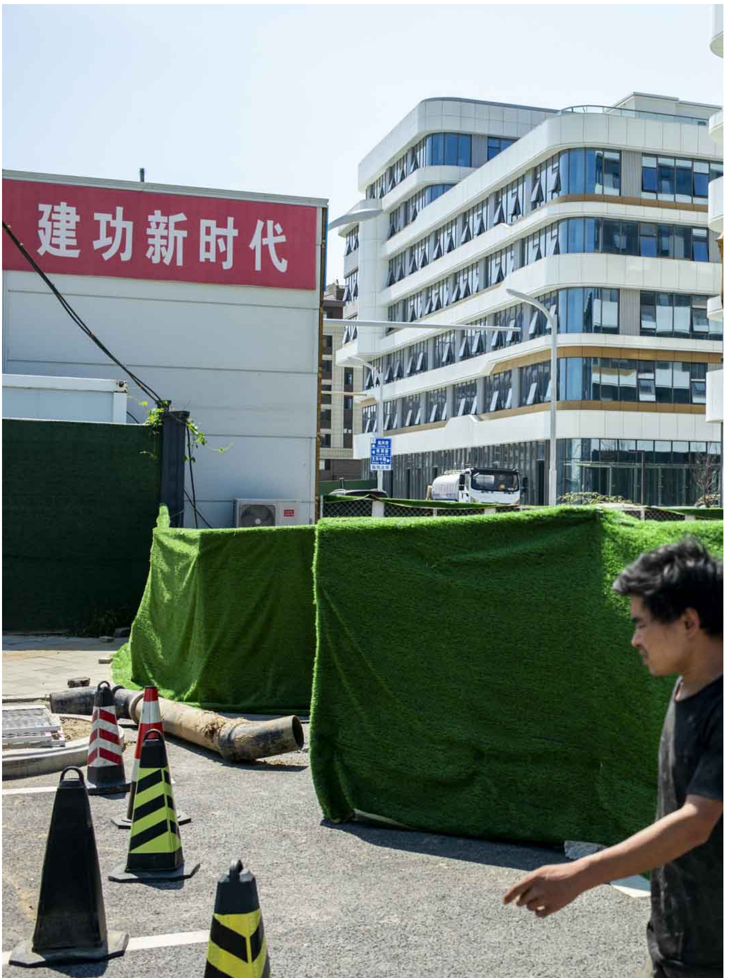
2023年，容西安置區的建築工人。攝：林文清/端傳媒
