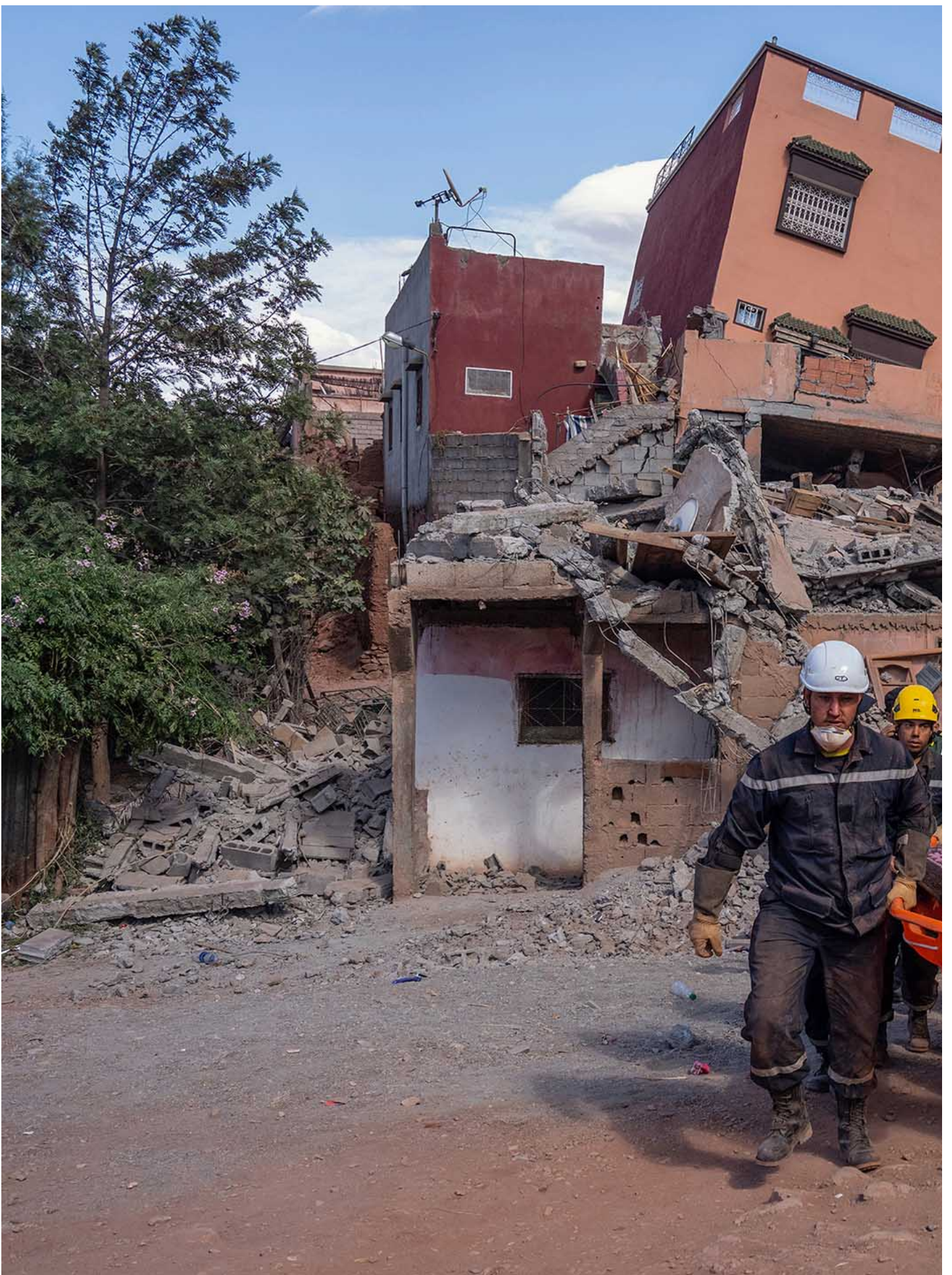
2023年9月10日，救援人员在摩洛哥一栋倒塌的建筑物内发现一名妇女的尸体。摄：Carl Court/Getty Image
