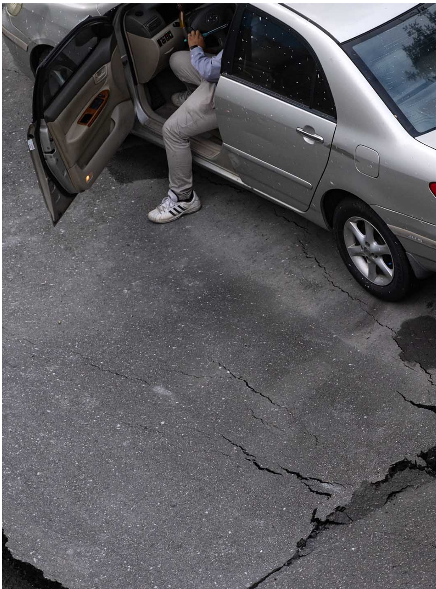
2023年9月8日，台北大直民宅塌陷。摄：陈焯輝/端传媒
