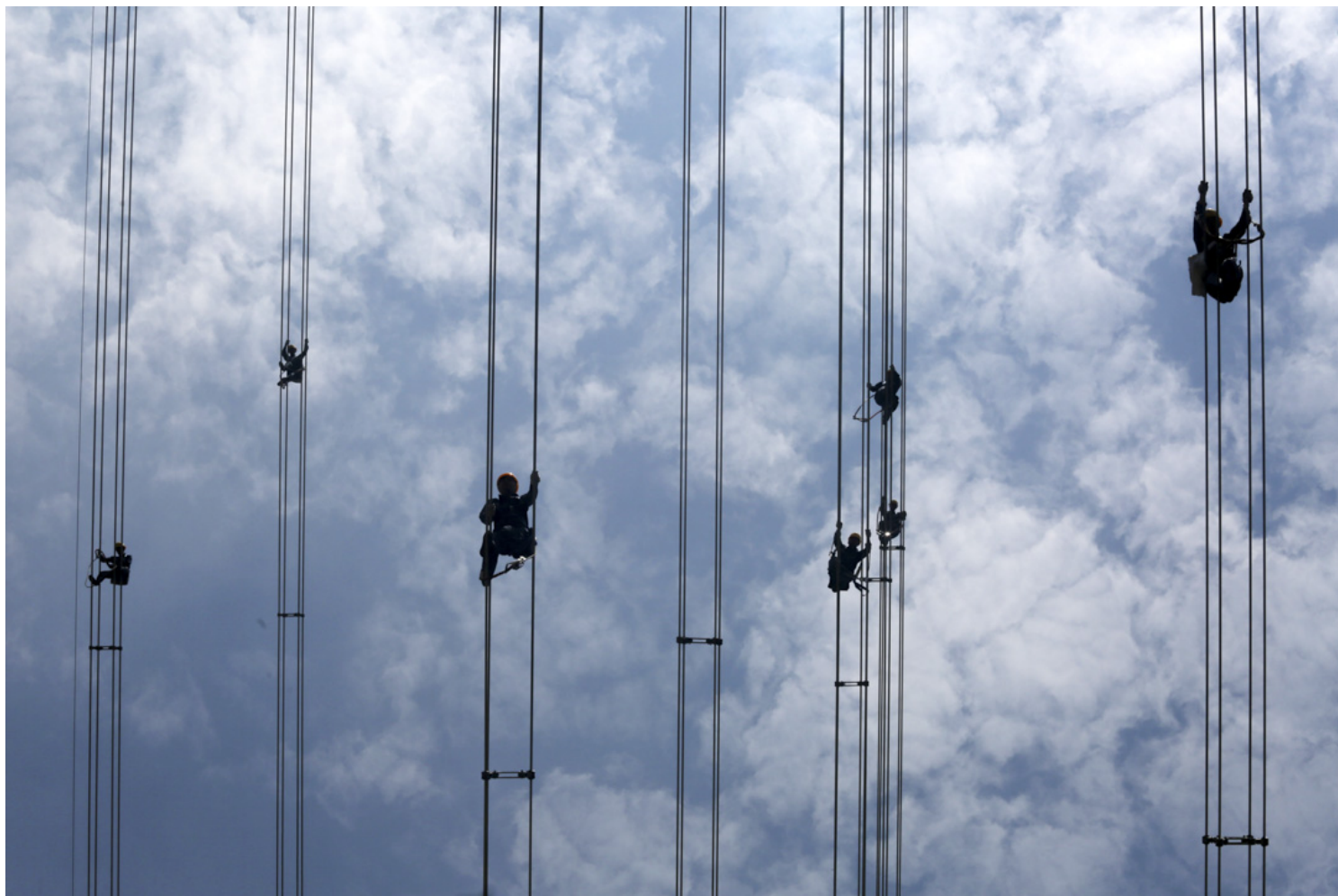
2018年5月29日，中国广东省东莞，南方电网的工人检查连接输电塔的电力电缆。摄：Stringer /Reuters/达志影像
