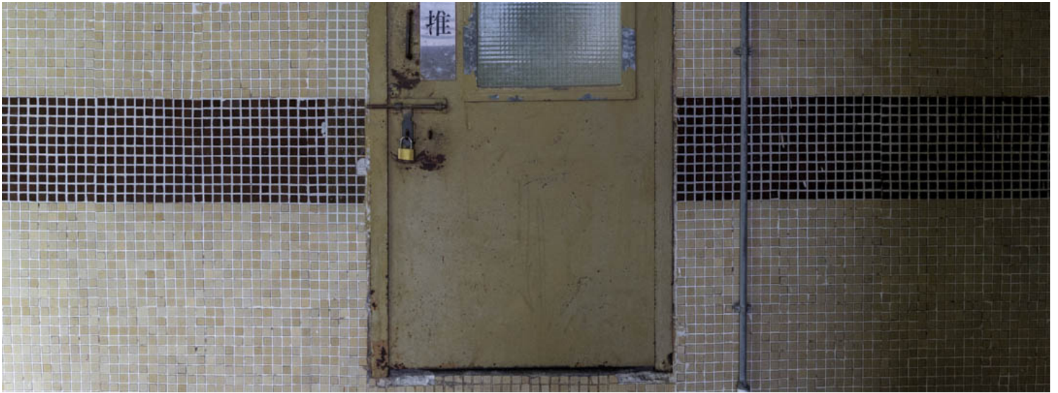
屯门山景邨景乐楼35楼垃圾房。摄：林振东/端传媒
